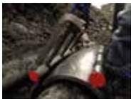
Durch gegenseitiges Ziehen am Schrauben­halter und Montage­griff wird das Gehäuse enger um das Rohr gebogen.
