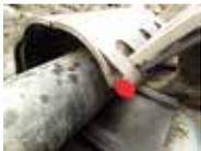
Dicht­manschette und Gehäuse dabei mög­lichst nicht ver­schmutzen (Ver­schmut­zungsschutz am Boden).
