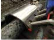
Gehäuse auf­klappen und hand­griff­seitig voran das Gehäuse und die Man­schette unter dem Rohr durch­schleiben.
