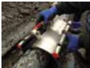
Dicht­manschette in das Gehäuse unter dem Schrauben­halter schieben. Darauf achten, dass die Gum­mi­manschette sauber zwischen den Gehäuse­ränder positioniert wird.
