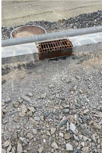
ADUXA STRASSENABLAUF MOD. 355 MIT AUFSATZ 300 X 500 EINBAUZUSTAND BIS SCHOTTERTRAGSCHICHT
