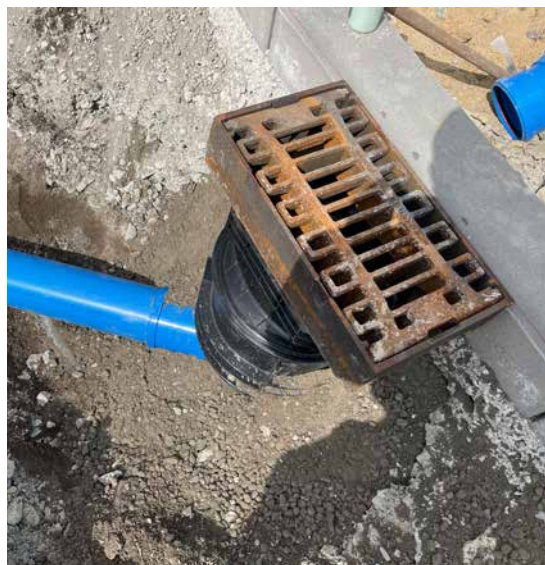
ADUXA STRASSENABLAUF MOD. 355 EINBAU MIT AUFSATZ 300 X 500
