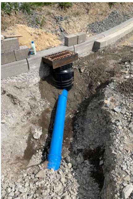
ADUXA STRASSENABLAUF MOD. 355 EINBAU MIT AUFSATZ 300 X 500
